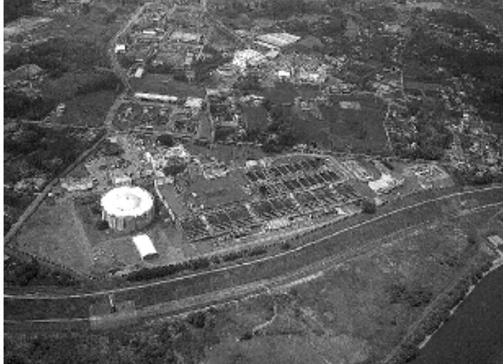
春日部市にある庄和浄水場。江戸川の水を約110万人へ給水する（写真提供：埼玉県）
