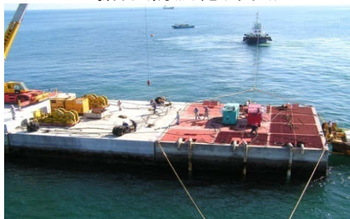
・ケーソン据付(防波堤(中央))
