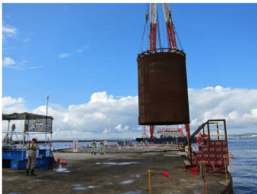
・岸壁の整備状況(鋼板セル)
