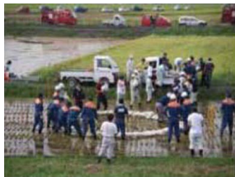
●群馬県明和町漏水状況 (H19)
