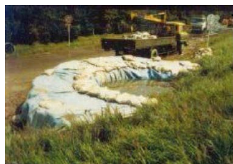
●千葉県松戸市漏水状況 (S57)
