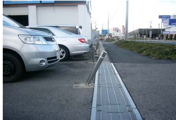
ポール損傷状況
