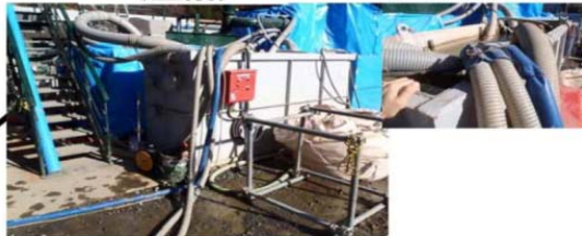
排水ホース設置状況 (全景) (固定状況)
