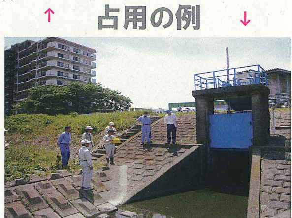
樋門・水門（用水の取り入れや排水の通路） 定期的に履行検査をします
