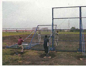
バックネット等は転倒式になっており、洪水時には倒して流水の阻害になるのを防ぎます
