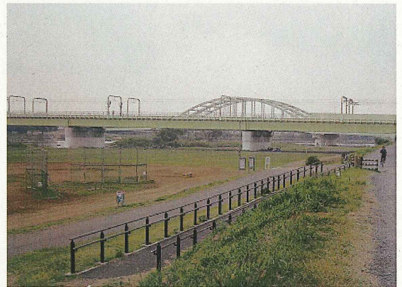
グラウンドと鉄道橋
