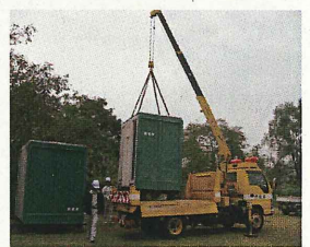
トイレも洪水時には河川の外に移動できるようにになっています
