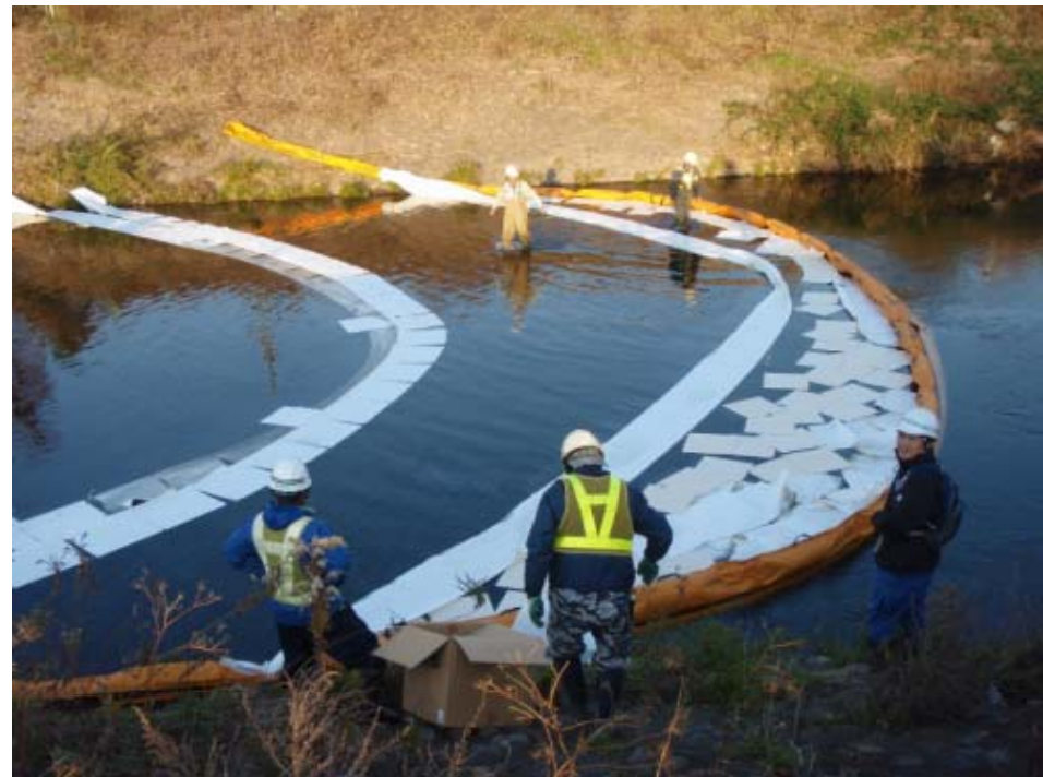
国によるオイルフェンス・オイルマットの布設状況(野川)
