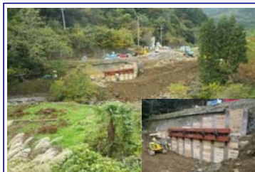
とどろが 渡々沢川橋
