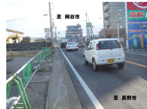
【供用前】区間③の状況 (平成18年度撮影)
