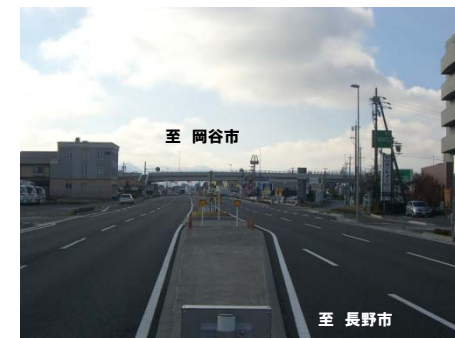
【供用後】区間③の状況 (平成23年11月撮影)
