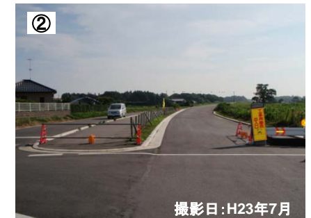
写真② 学園東大通り付近から東京方面を望む
