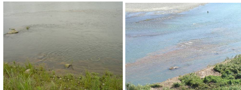
15.2k 右岸低水河岸、H15 年撮影 15.5k 右岸低水路内、H19 年撮影 写真-2.1：三川合流点周辺の土丹層露出状況
