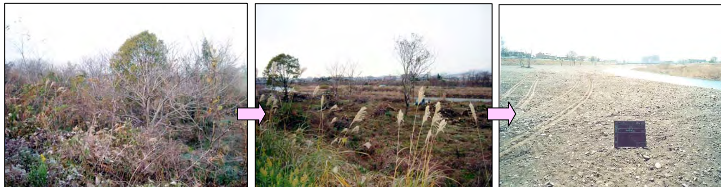
写真 3-3 礫河原再生工事の状況
