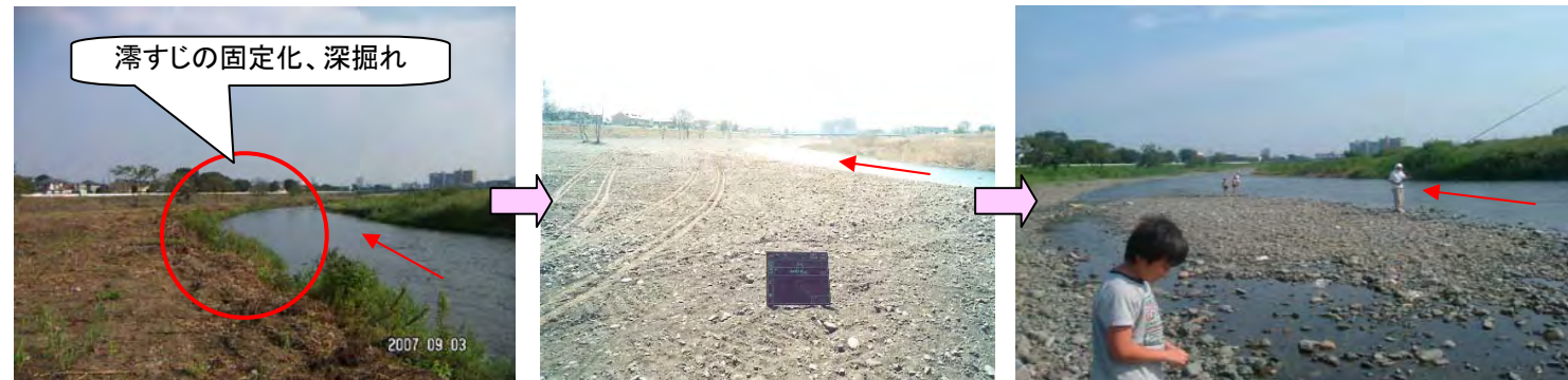
写真 3-4 施工後の状況
