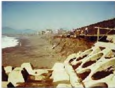
写真 3-6 昭和 57 年台風 18 号被災事例
