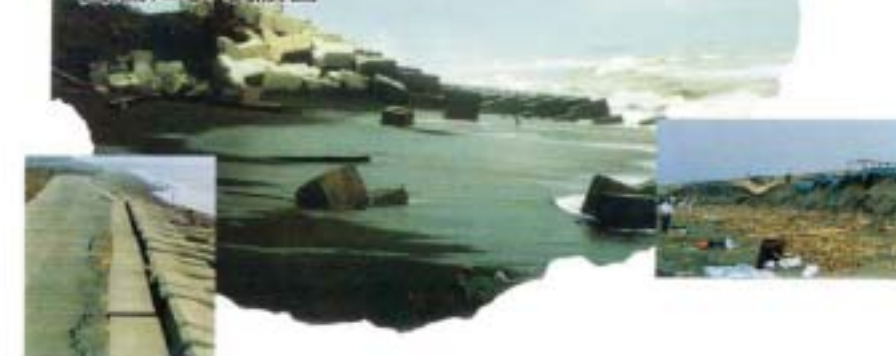
写真 台風による被害状況
