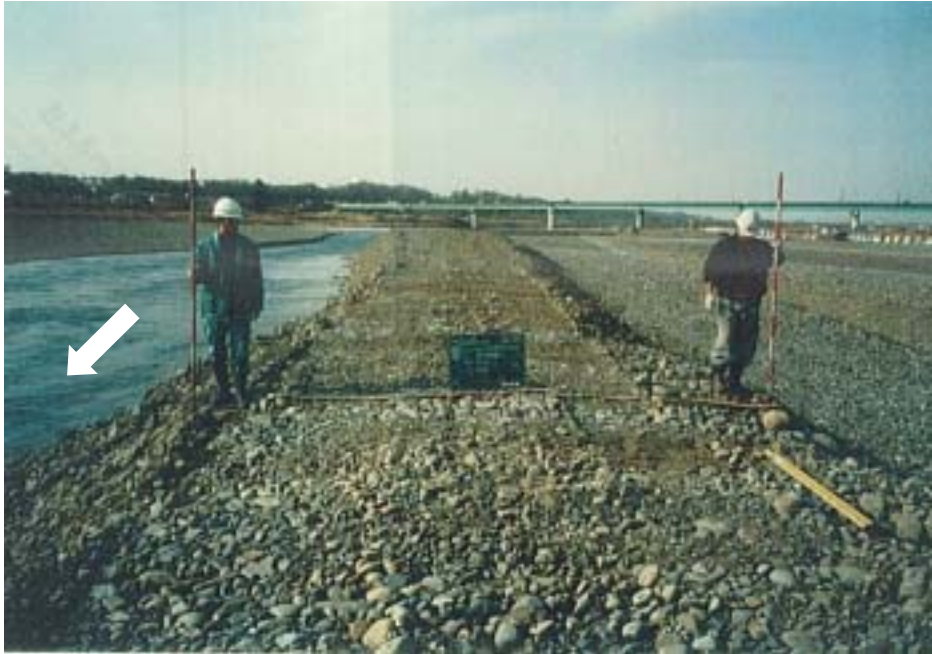
H14年度施工時点
