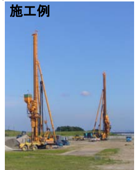
大きな“杭打ち機”で砂杭を打設します
