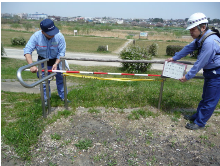
転落防止柵点検状況(多摩川)
