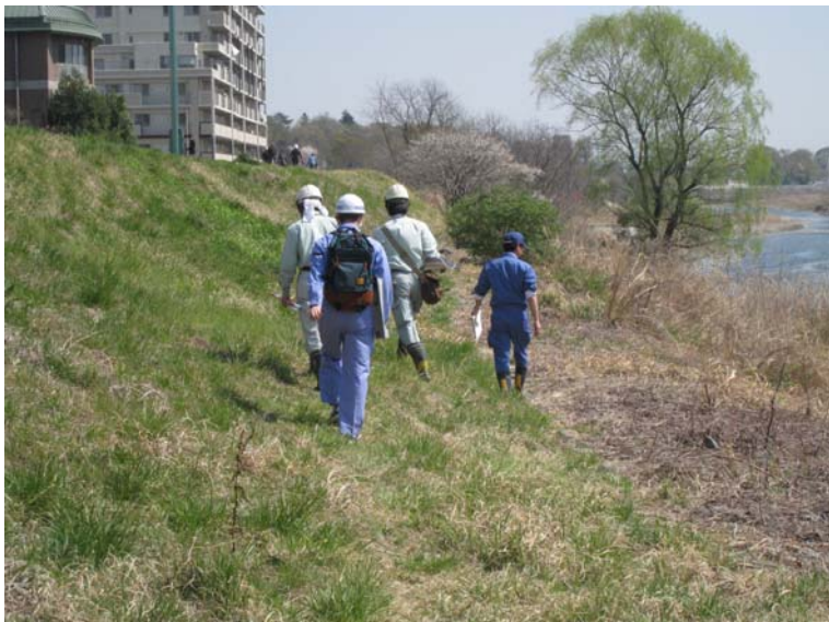
高水敷き点検状況(多摩川)
