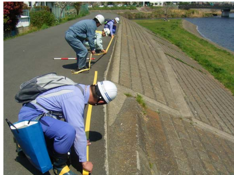
河川利用者が段差に気づきにくい箇所に注意を促すための蛍光テープを貼付(鶴見川)
