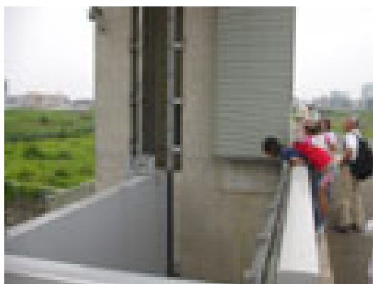
大きな排水門 (遊水地に貯まった水は、 ここから鶴見川に戻します。)
