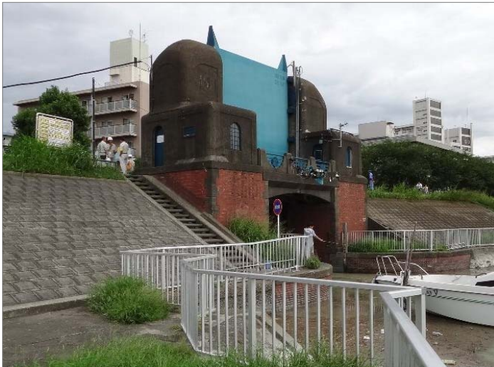
六郷水門全景(多摩川左岸4.0k 大田区南六郷地先)
