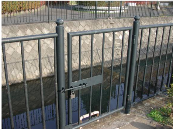
図 9 開閉式フェンス（町田市：真光寺川）
