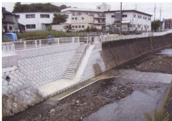
図 11 階段と取水ピット（横浜市：帷子川）
