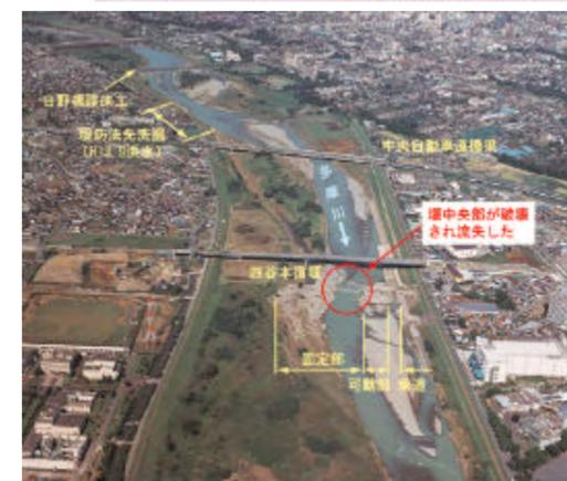
洪水継続時間の長い出水により、堰の中央部が破壊され流失しました。
