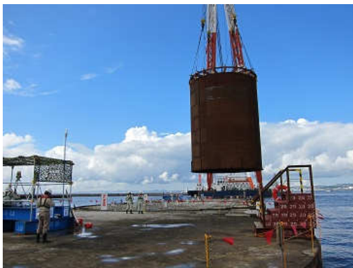
・岸壁の整備状況(鋼板セル)
