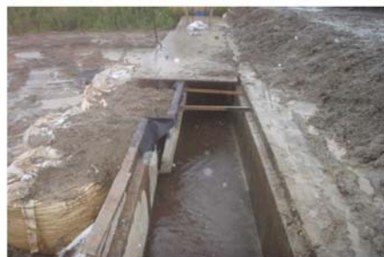
水路破損状況
