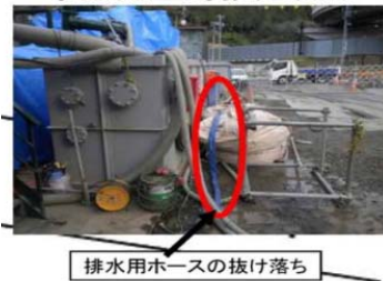
事故発生時推定状況
