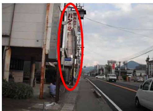
看板損傷状況
