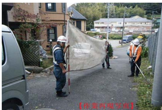
現場作業状況
