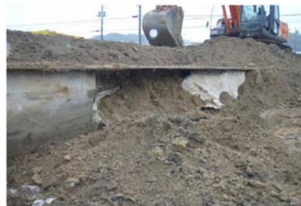
水路破損状況
