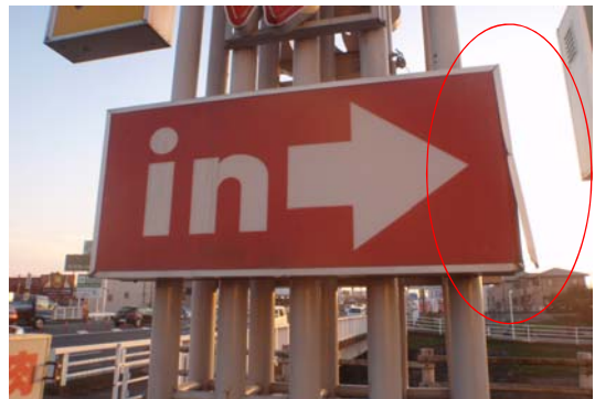
看板損傷状況
