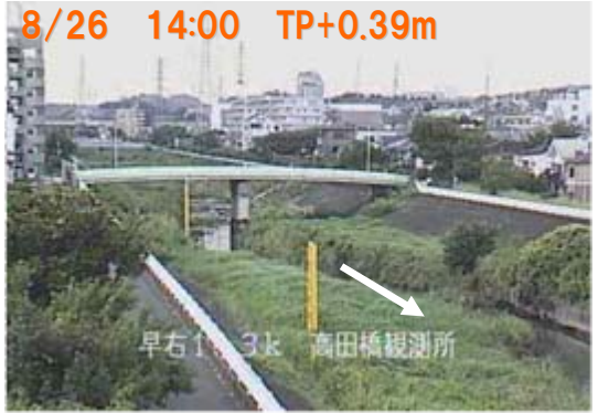
早淵川: 高田橋(港北区)
