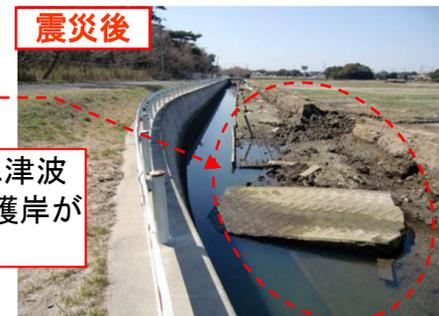
堤内水路に津波が逆流し、護岸が崩壊
