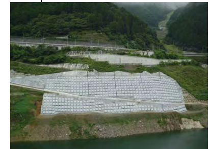
P-2 アンカー工
