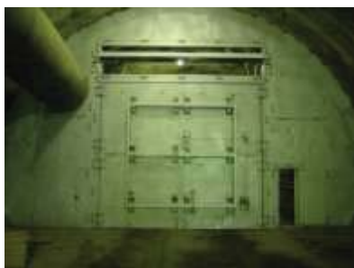
写真 3-2-3 防音扉の状況
