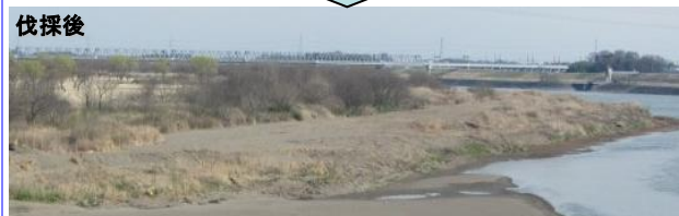
※伐採後に河道掘削
