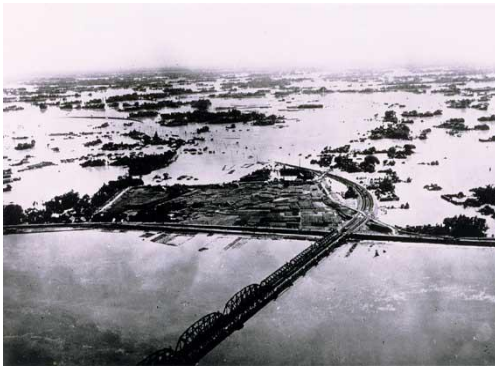
写真 2-2-1 埼玉県久喜市（旧栗橋町） （利根川）
