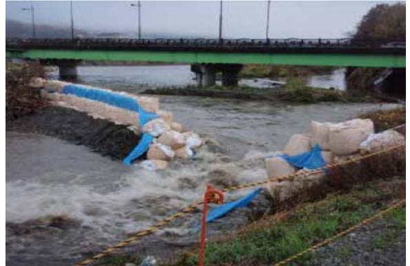
仮締切盛土の上流及び下流側2箇所が決壊し、工事ヤード内へ浸水
