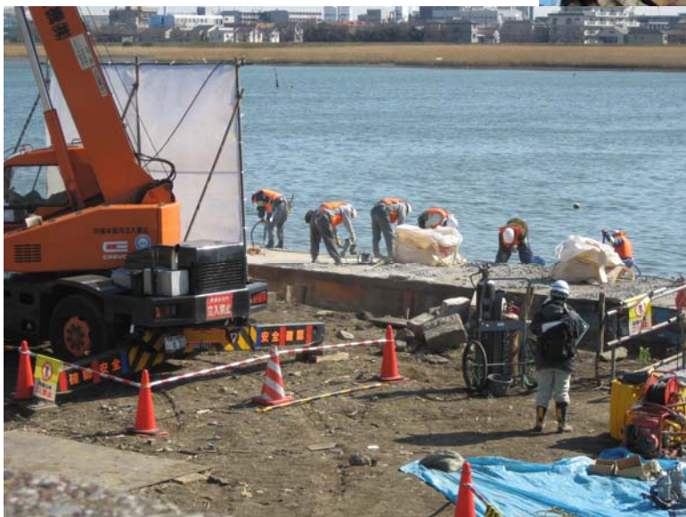
【台船解体作業状況：羽田】
