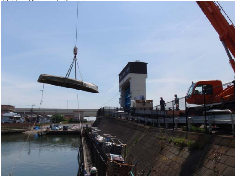
船舶の撤去作業(陸上)
