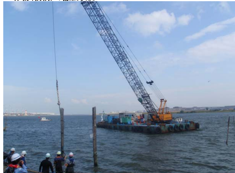
工作物(棧橋)の撤去状況
