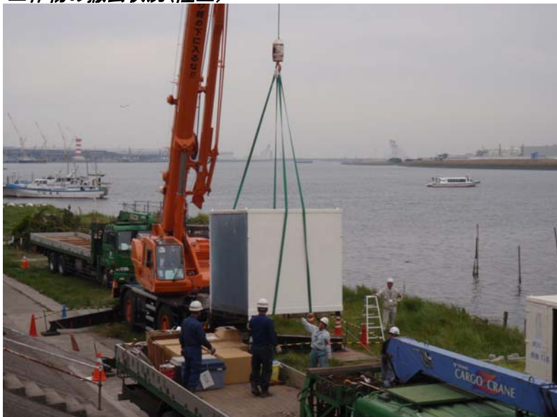
工作物の撤去状況(陸上)
