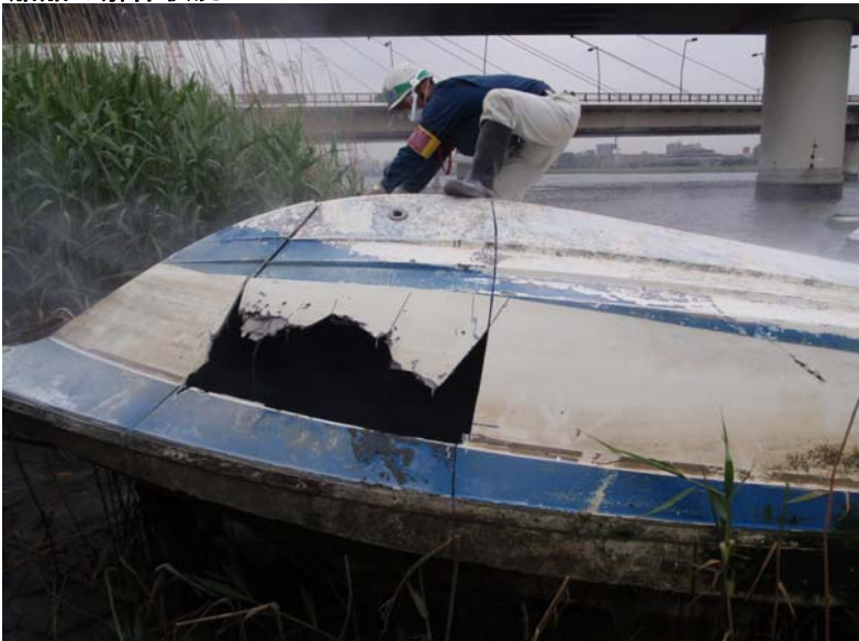
船舶の解体状況
