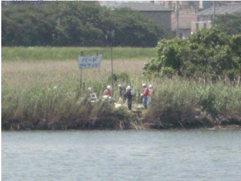
工作物の撤去状況(陸上)
