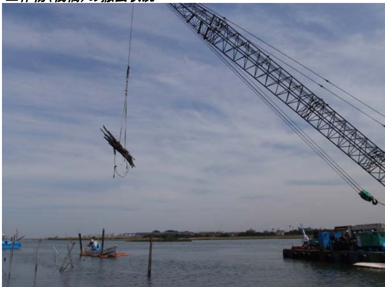
工作物(棧橋)の撤去状況
