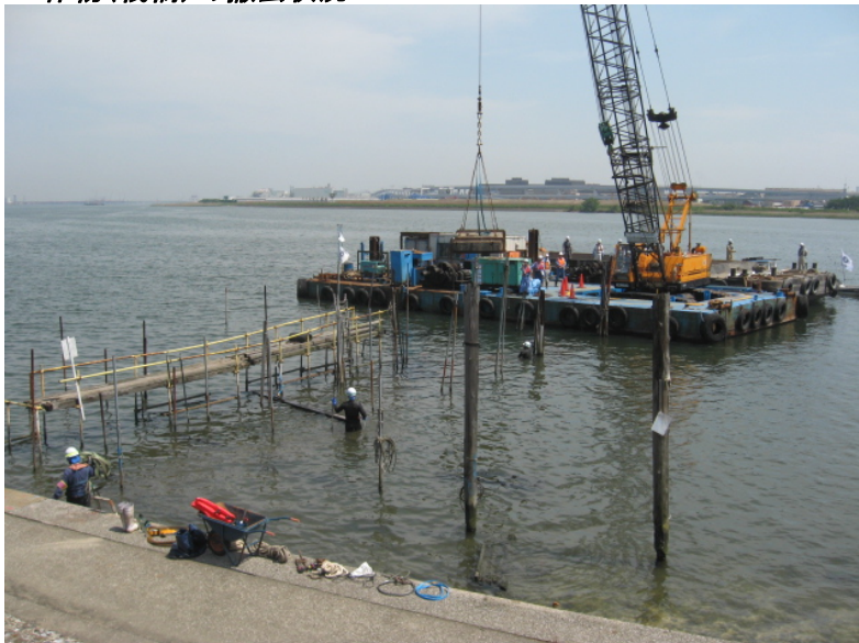
工作物(棧橋)の撤去状況
