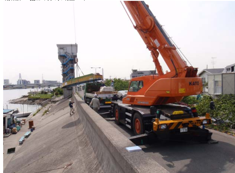
船舶の撤去作業(陸上)
