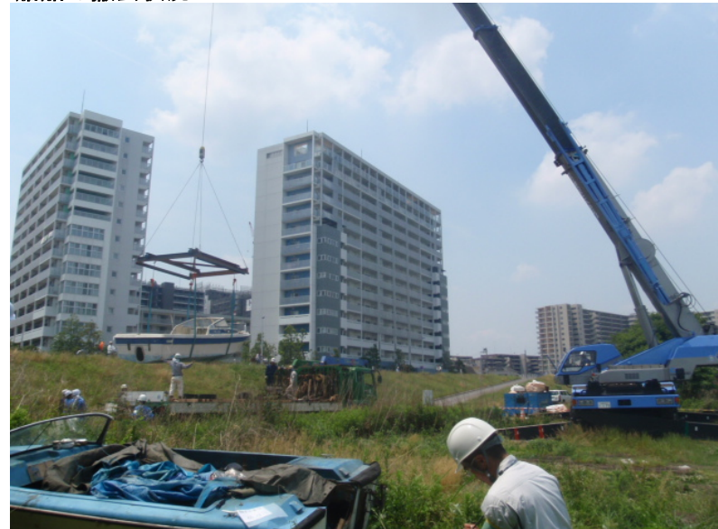
船舶の撤去状況
