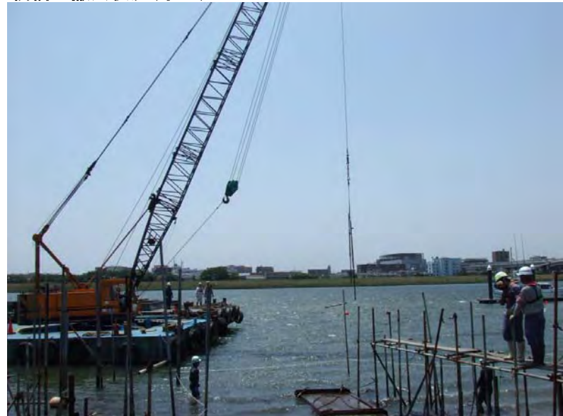
棧橋の撤去状況(水上)
