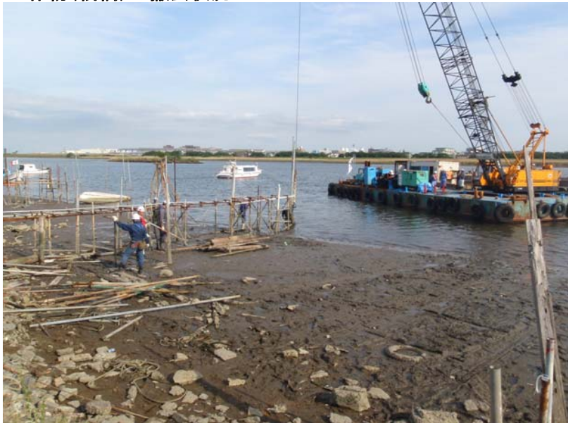
工作物(桟橋)の撤去状況
