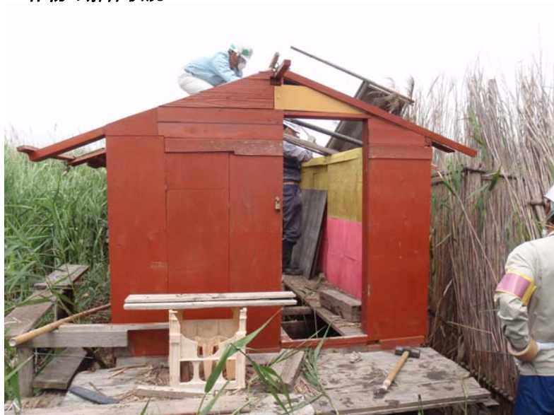
工作物の解体状況
