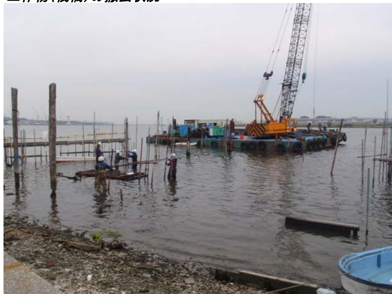
工作物(棧橋)の撤去状況
