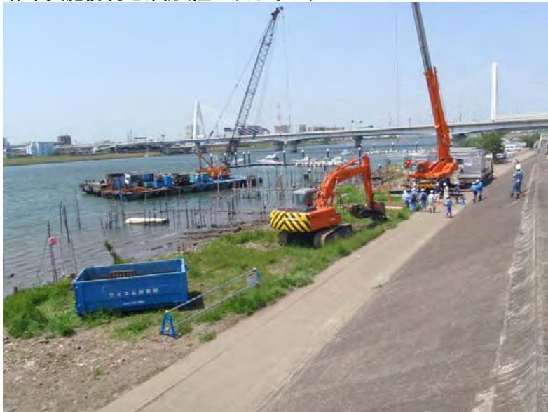
作業実施前現地確認(陸上及び水上)
