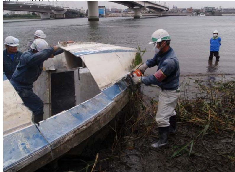
船舶の解体状況
