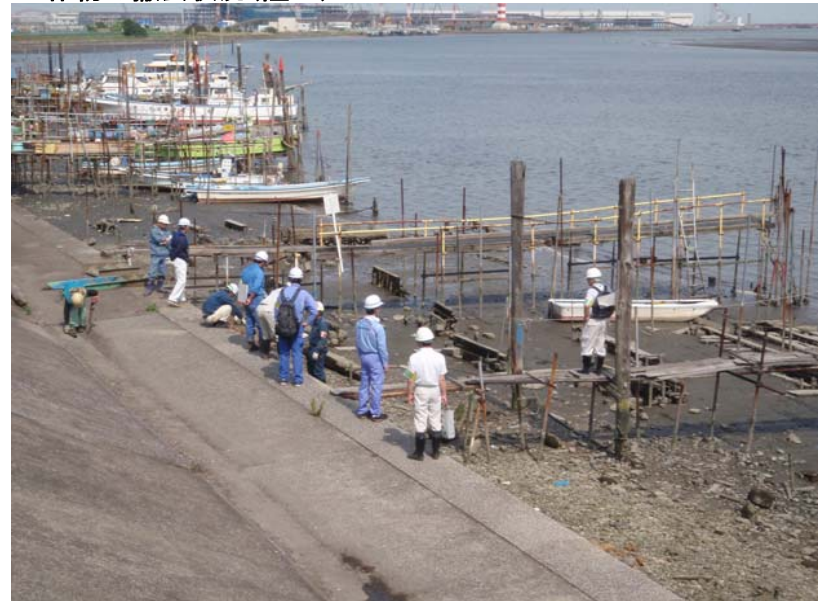
工作物の撤去状況(陸上)
