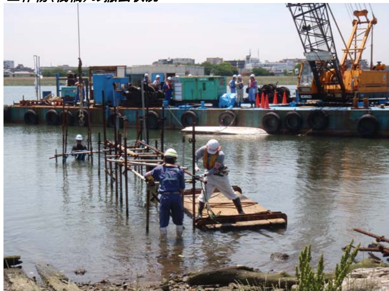
工作物(棧橋)の撤去状況
