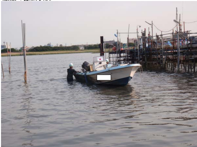
船舶の撤去状況
