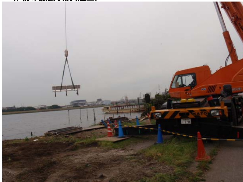
工作物の撤去状況(陸上)
