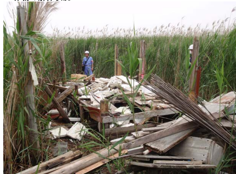
工作物の解体状況
