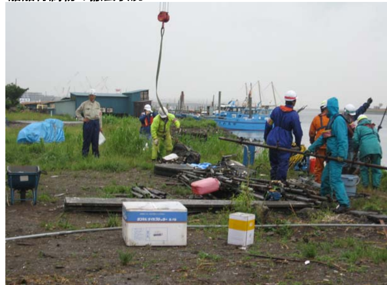
船舶付属物の撤去状況
