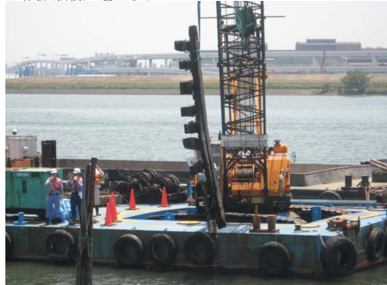
工作物(棧橋)の撤去状況
