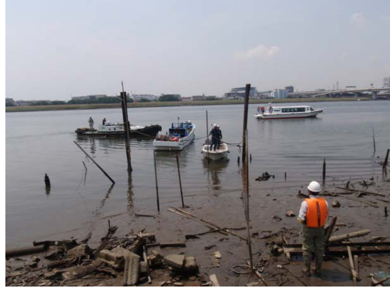
船舶の撤去状況
