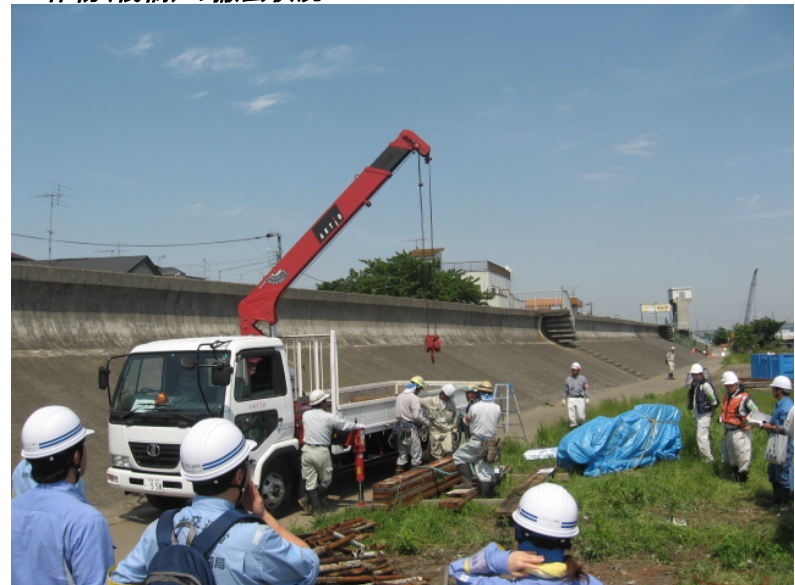
工作物(棧橋)の撤去状況
