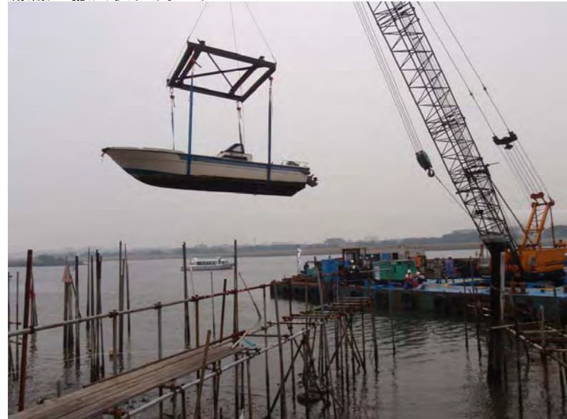
船舶の撤去状況(水上)
