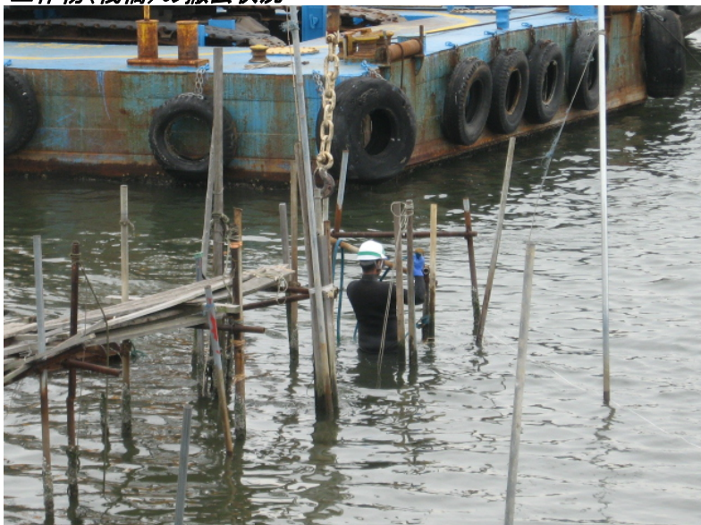
工作物(棧橋)の撤去状況
