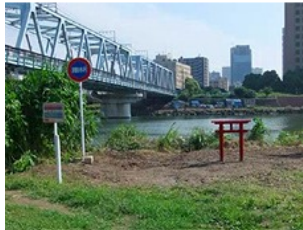
ゴミ撤去後のようす (平成22年6月23日)
