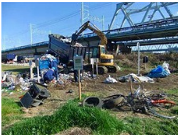
大田区によるゴミ撤去作業 (平成22年12月29日)
