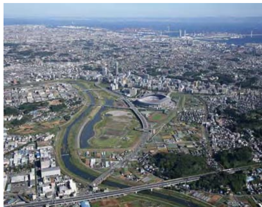
平成15年6月に完成した鶴見川多目的遊水地
