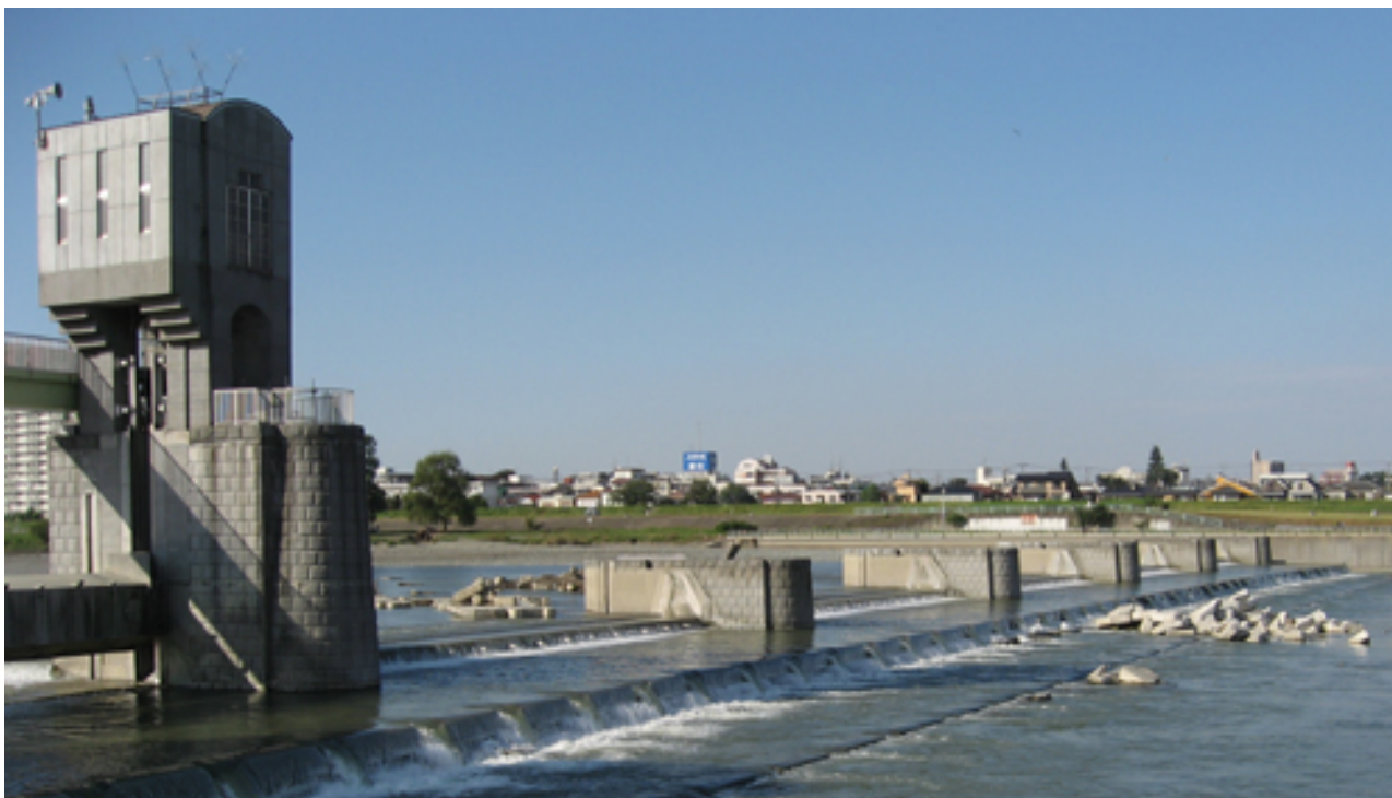
ゲートを倒した状態の二ヶ領宿河原堰
