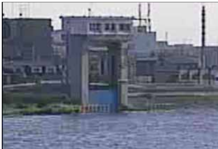
羽田第一水門の閉鎖状況 (8/12 6:00頃 河川管理用カメラ画像)
