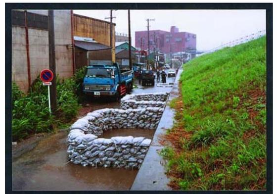
漏水が発見されたので水防団が土のうを積んだ(月の輪工法)
