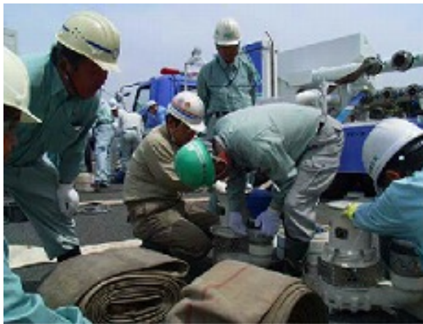
ポンプ車ホース接続
