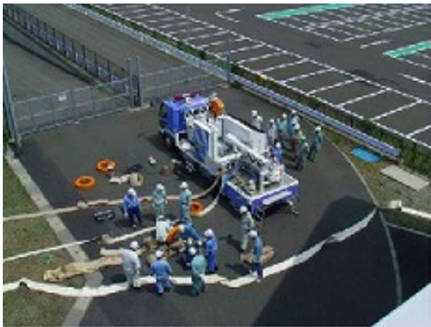
排水ポンプ車設営
