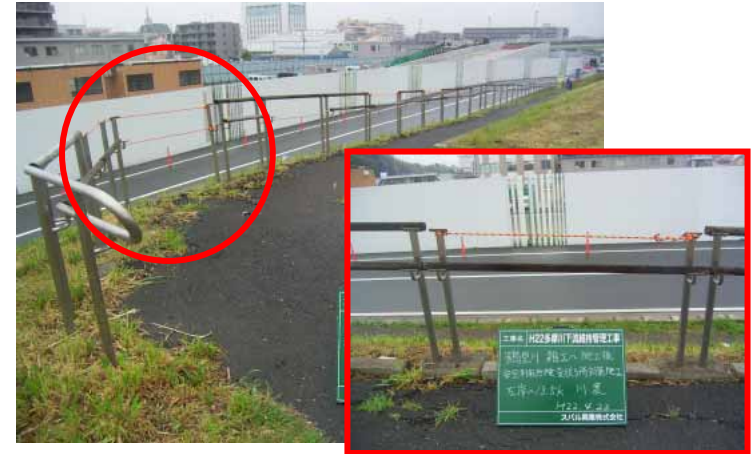
応急措置としてロープを設置しました。
