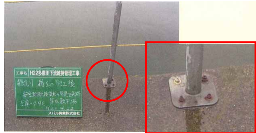
新たにボルトを締め、補修しました。
