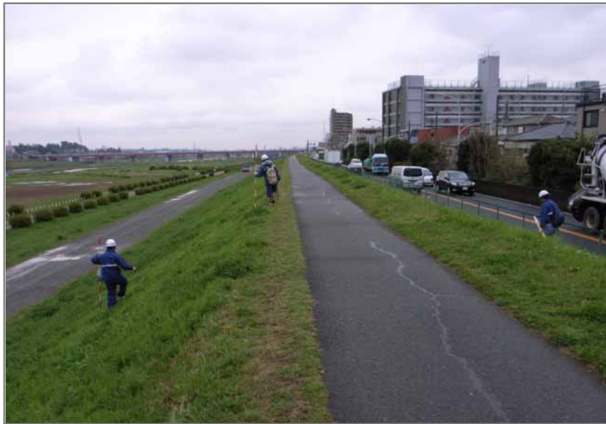
堤防天端周辺点検状況(多摩川)
