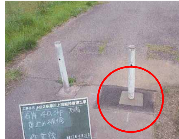
車止めの基礎を補修し、固定しました。
