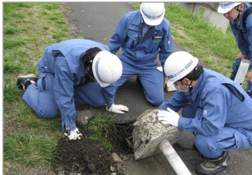
車止め基礎点検状況(多摩川)
