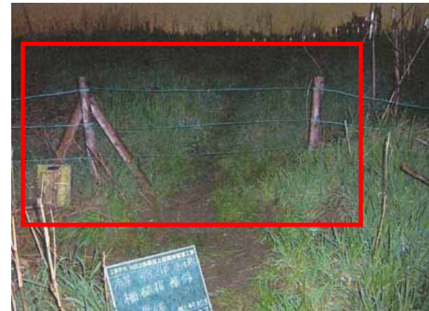
進入を防止するため、柵を補修しました。
