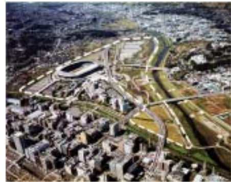
写真-3 工事中の鶴見川多目的遊水地
