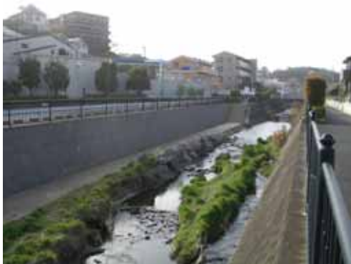
写真 4.9 梅現橋下流の親水施設 （真光寺川）
