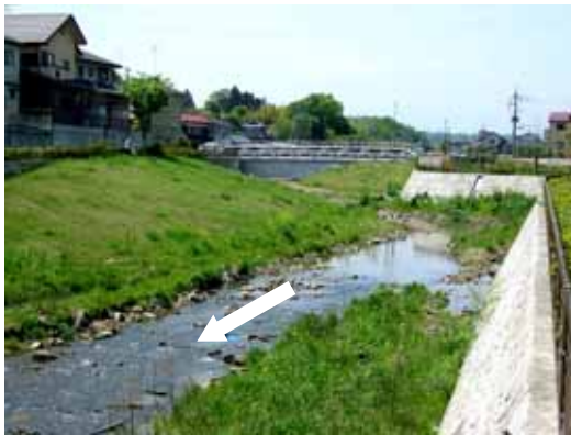
写真 4.5 変化を持った流れや緩傾斜護岸を創出 (参道橋下流)
