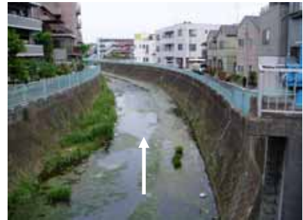
写真 1.8 上野川橋より下流側
