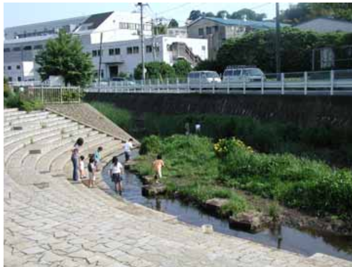
写真 4.15 既設親水護岸（真部橋下流）
