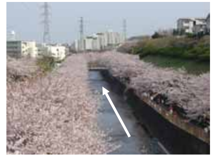
写真 1.13 会下山橋より下流側
