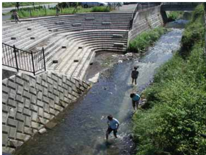
写真 4.14 既設親水護岸（天屋二ノ橋下流）
