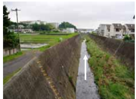
写真 1.11 新大熊橋より下流側
