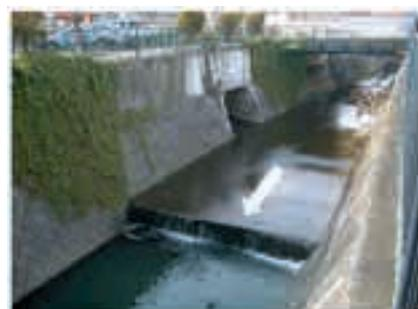
写真 4.10 水生生物の移動を妨げる落差工
