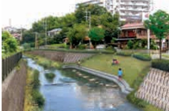
図 4.27 傾斜護岸整備イメージ
