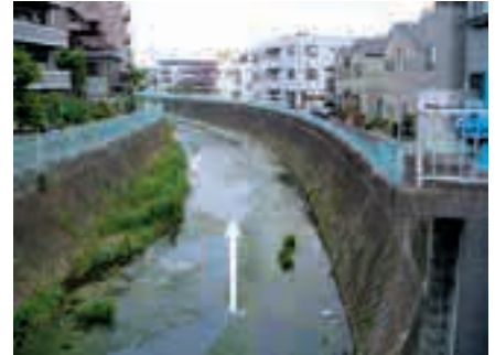
写真 1.8 上野川橋より下流側
