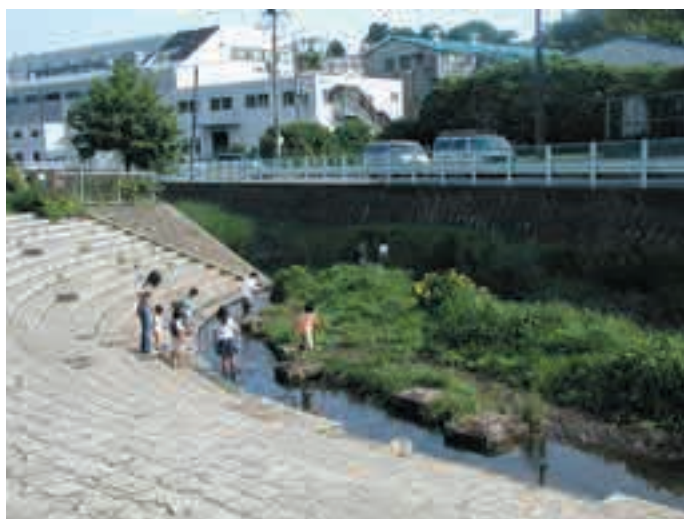
写真 4.15 既設親水護岸（真部橋下流）
