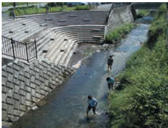
写真 4.14 既設親水護岸（天屋二ノ橋下流）
