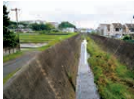
写真 1.11 新大熊橋より下流側
