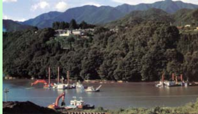
しゅんせつ船団作業状況
