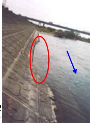
低水護岸破損状況 (厚木市戸田)
