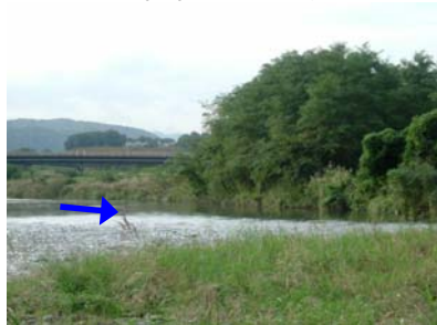
高水敷の樹林化(厚木市下川入)
