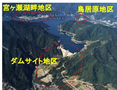
周辺整備を行った3拠点
