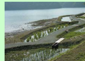
三井地区植物浄化施設
