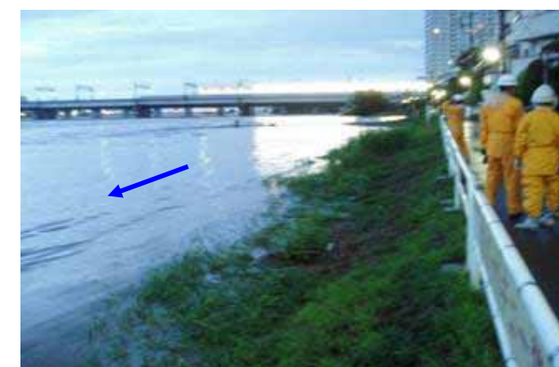
多摩川左岸 17.6 k 付近 世田谷区二子玉川地区
