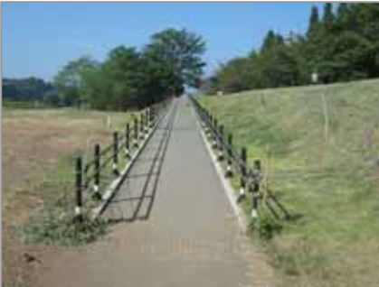
緩傾斜坂路（府中市地先）
