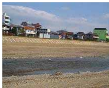
八王子市大和田 3 丁目地先の低水護岸と高水護岸
