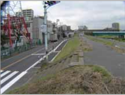
緩傾斜坂路（大田区矢口地先）
