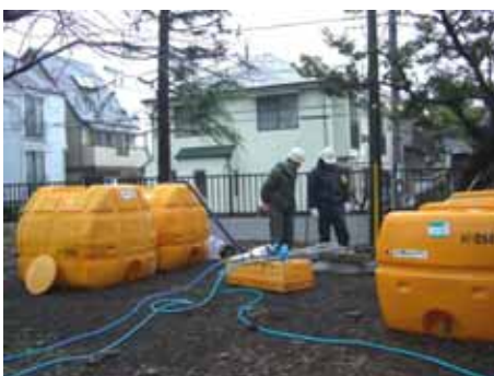
注水作業の様子
