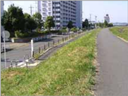
緩傾斜坂路（八王子市地先）
