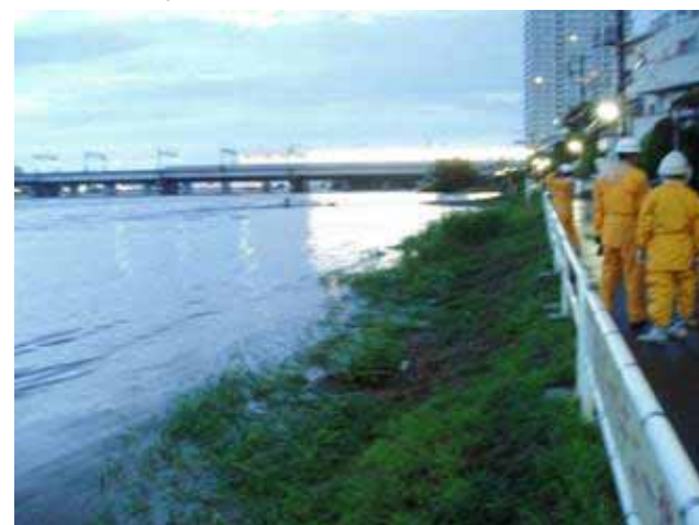
H20.8.29 8 月末豪雨での出水状況 (世田谷区玉川一丁目)
