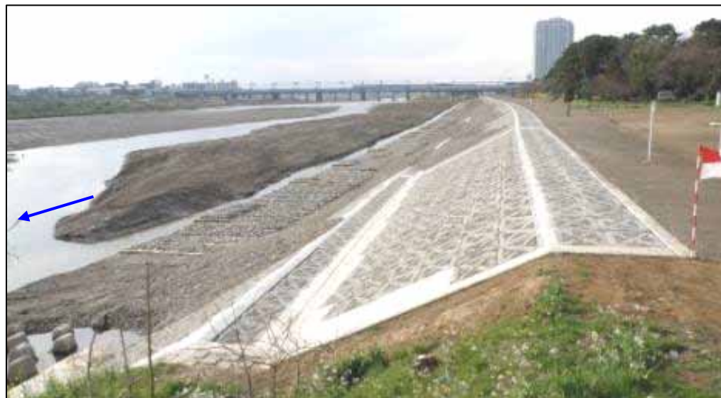
低水護岸および堤防基盤造成
