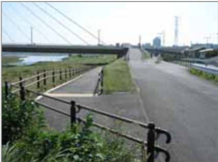
緩傾斜坂路（日野市地先）
