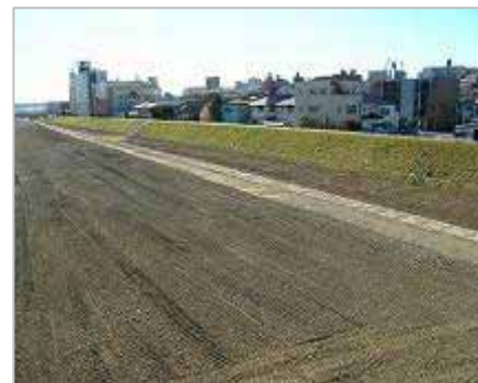
八王子市元横山町地先の低水護岸
