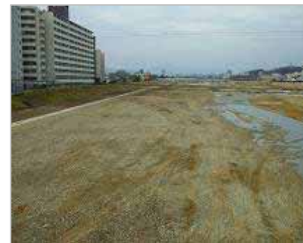
八王子市明神町 4 丁目地先の低水護岸
