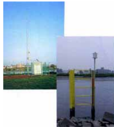
水位・流量観測施設
