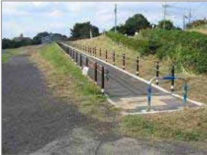
緩傾斜坂路（国立市地先）
