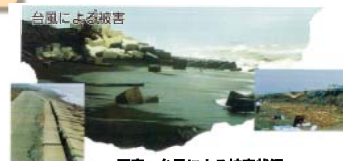
写真 台風による被害状況
