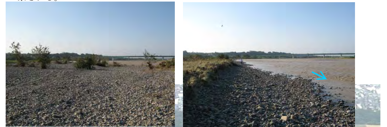
④置き砂下流高水敷上の砂利堆積状況（土砂堆積により、高水敷上の草地環境が砂礫河原環境に変化した）
