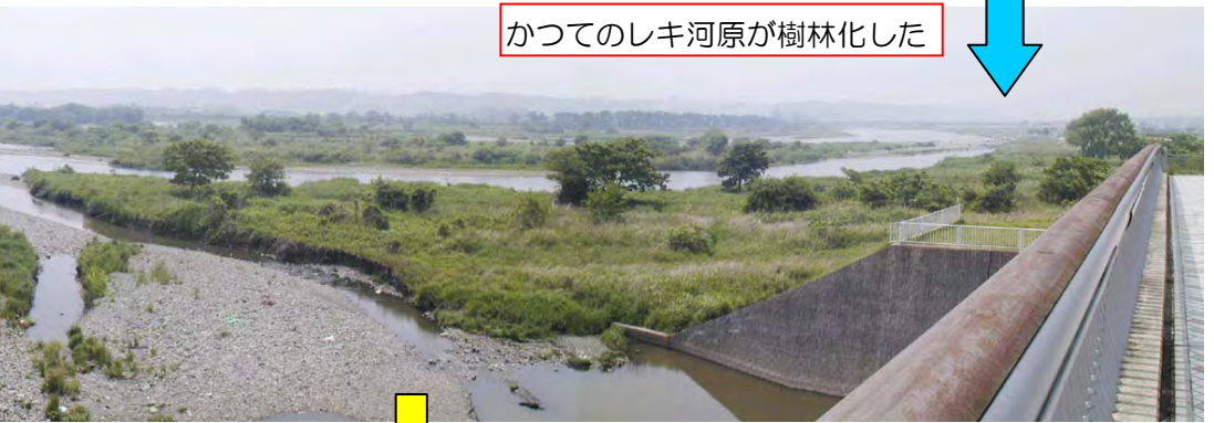
写真 2-6：磯部頭首工下流右岸の樹林化状況
