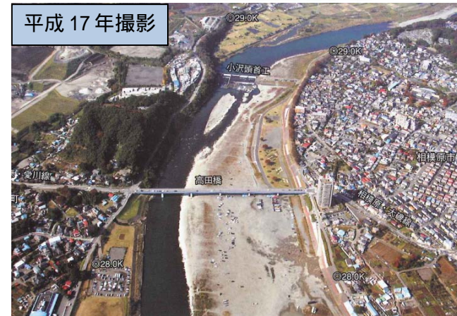
図-2.1.4(1) 斜め写真 28k 小沢頭首工下流
