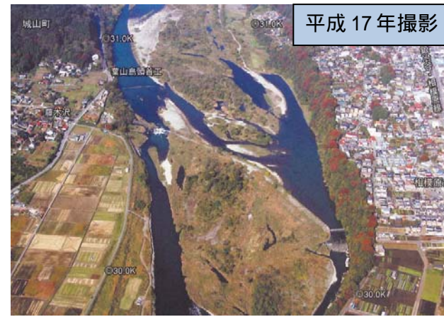
図-2.1.4(2) 斜め写真 30k 付近
