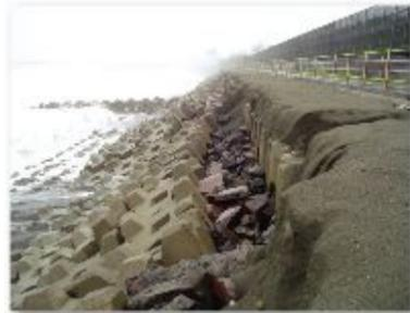
写真-1.9 平成17年台風14号被災事例
