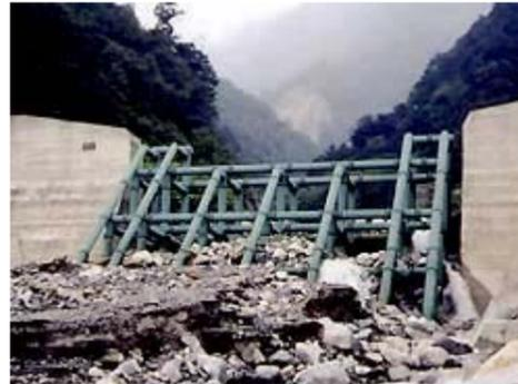
写真-1.1 鉄格子型砂防えん堤
