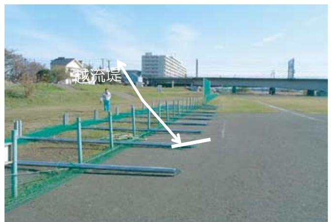
野球場の防球ネット ネットを外し柱は倒すことで対応します。
