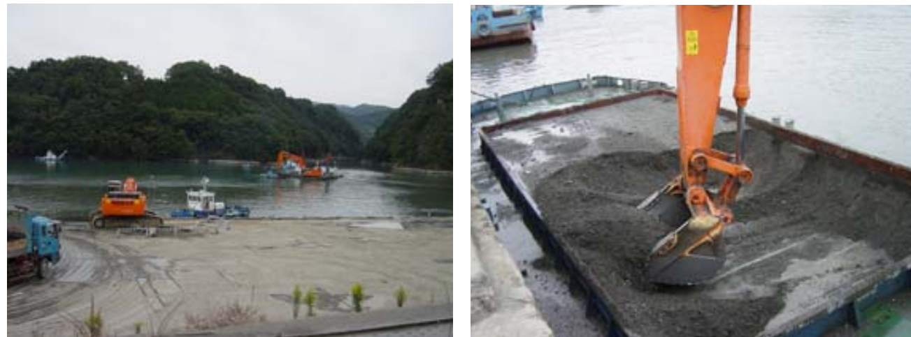
図 2.12 浚渫の状況 (H15 年 10 月)
